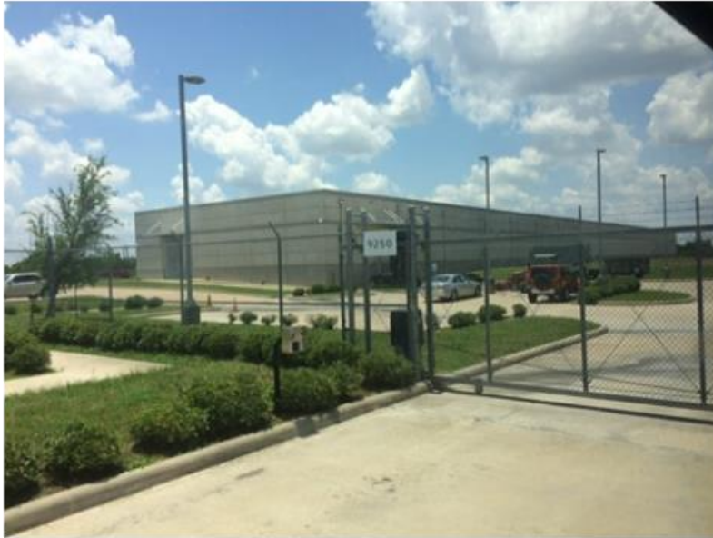
מבנה המחסנים החיצוניים של המוזיאון לאומנויות יפות BFAH, יוסטון, טקסס. מבנה מודולרי עם אפשרויות להרחבה
